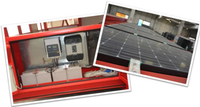
Figura 3 Alcuni dettagli tecnici dell'unità mobile che ne consentono la completa autosufficienza energetica.
